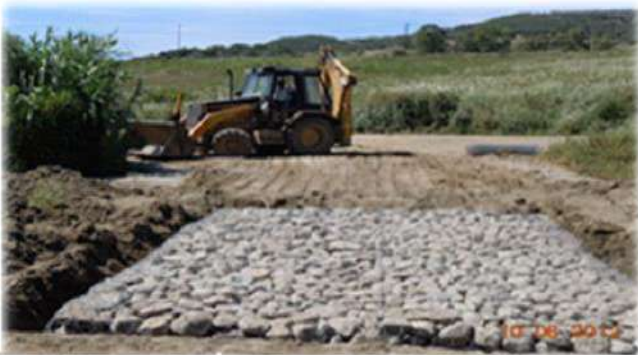
FIXATION MECANIQUE DES BERGES
