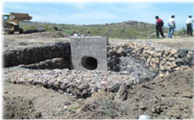
FIXATION MECANIQUE DES BERGES
